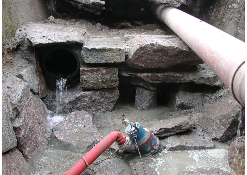
**Ausgeführte Arbeiten**  Im Zusammenhang mit der Erstellung des Hochwasserrückhaltebeckens musste eine Drainageleitung Durchmesser 600 in den Bach eingeleitet werden. Gleichzeitig wurde eine feste Ölsperre abgebrochen und eine Schwelle mit Fischunterstand erstellt
